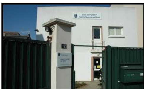
Le point d'accès au droit de la commune de Poissy
