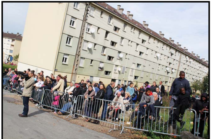
Rénovation urbaine aux Mureaux
